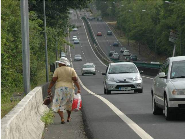
Absence de cheminements piétons
